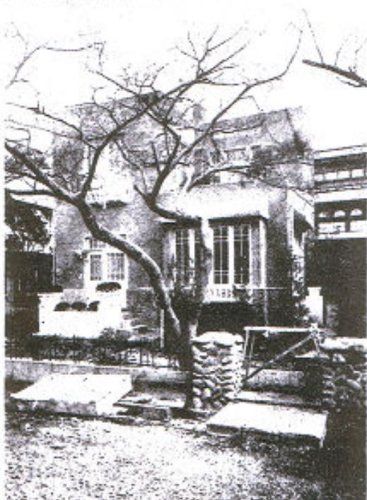
日本セメント工業出品住宅。出品された14棟の中で、唯一の鉄筋ブロック造。耐火耐震に優れ、2階に浴室、便所、庭を配することもできること、その特長を誇っている。1階居間の暖炉が2階にも通じ、1カ所で全室を暖房するじくみになっている。1階は女中室以外すべて洋風椅子式。約31坪。
