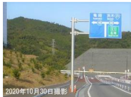
東側（46号線との接続口）
