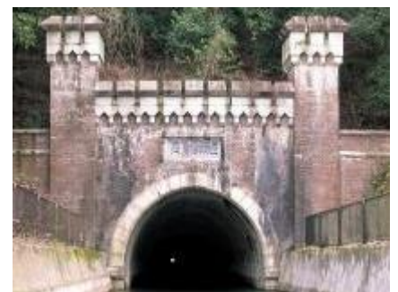
第三トンネル
